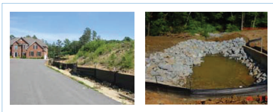
Figura 33. Muro de arrimo na imagem da esquerda e bacia de dissipação a direita (Dr Carlos TUCCI, 2019)
